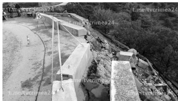
Обвал подпорной стены на этом участке произошел 5 февраля – установленные на обочине бетонные блоки упали с проезжей части и зацепили канализационный коллектор, был поврежден трубопровод.
